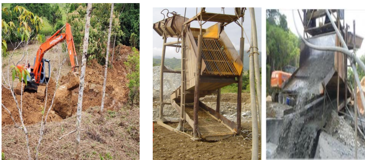
Fotografía 2.3, 2.4 y 2.5 Utilización de Retroexcavadoras y Canales de lavado. Este estudio 2025
