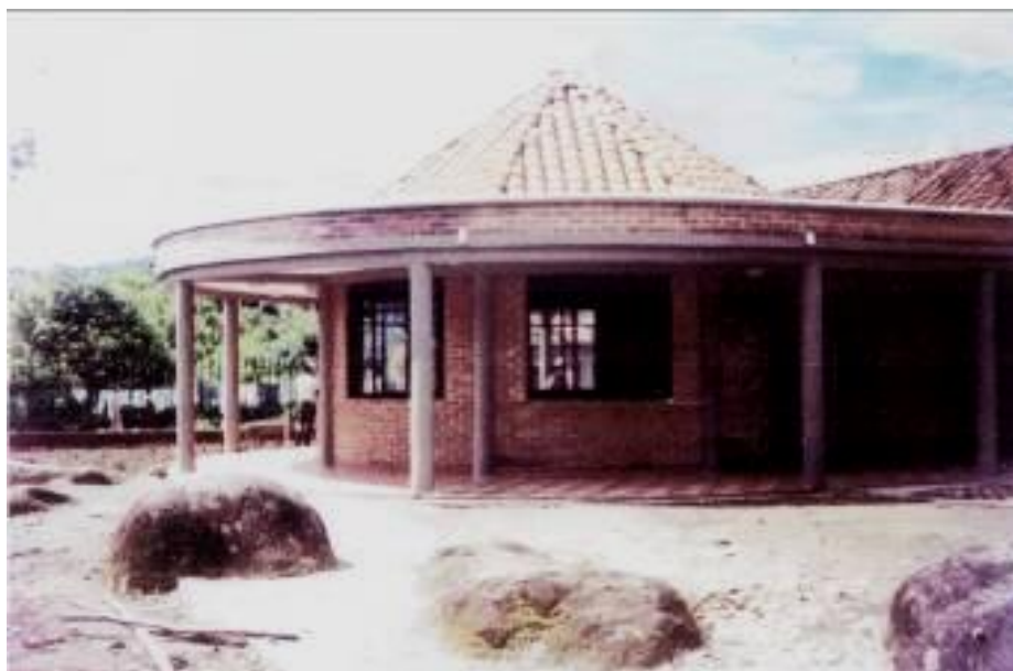
Fotografía 2.10 Instalaciones Centro Minero Ambiental de Puerto Limón, Putumayo, Colombia. Corpoamazonia 2010.
