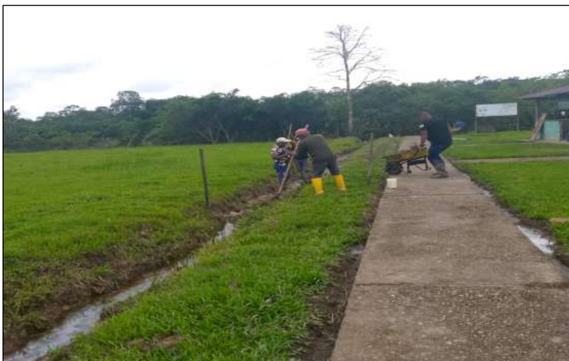
Foto 71. Limpieza del canal que rodea la comunidad.
