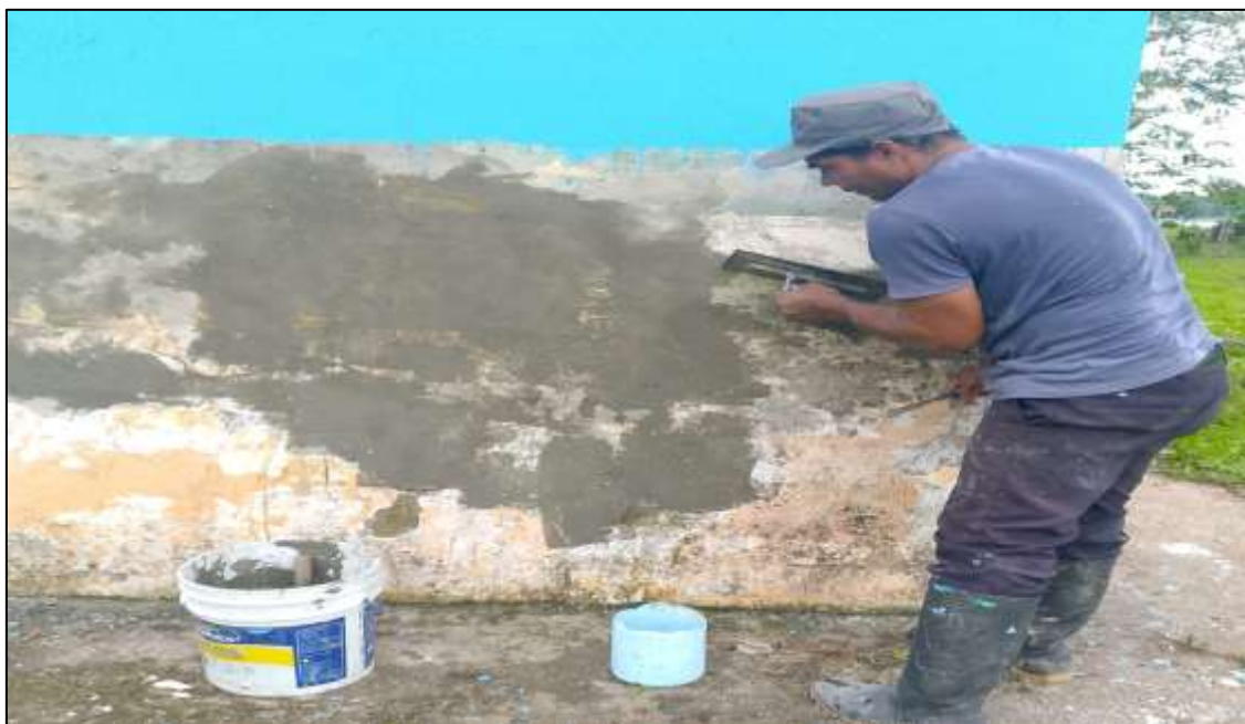
Foto 72. Trabajos de resane de paredes en la casa comunal.
