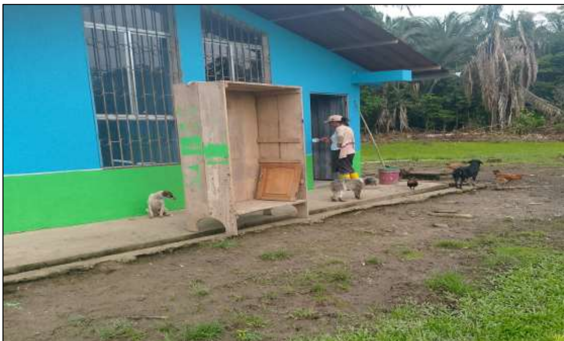
Foto 70. Trabajos de pintura y adecuación de la casa comunal.
